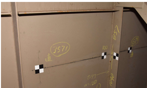
＜主桁ウェブ面の基準墨＞
