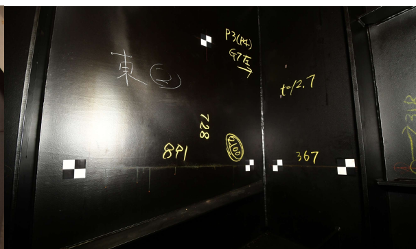
＜箱桁内面の基準墨＞
