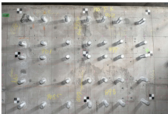
＜橋脚梁部のアンカー定着後の基準墨＞
