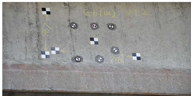
＜PCT桁側面のコア削孔＞
