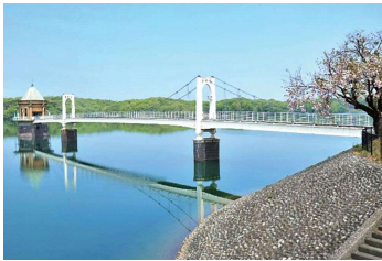
埼玉県狭山市 鋼自碇式吊橋 1934年(昭和9年) L=122.7m(30.48+60.96+30.48m) W=2m 松尾橋梁 2001年(平成13年)補修
