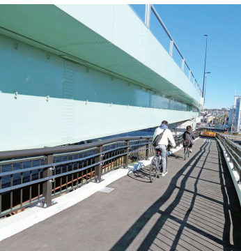
埼玉県狭山市 鋼自碇式吊橋 1934年(昭和9年) L=122.7m(30.48+60.96+30.48m) W=2m 松尾橋梁 2001年(平成13年)補修
