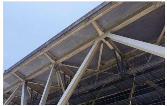
図-3 計測箇所(深沢橋)
