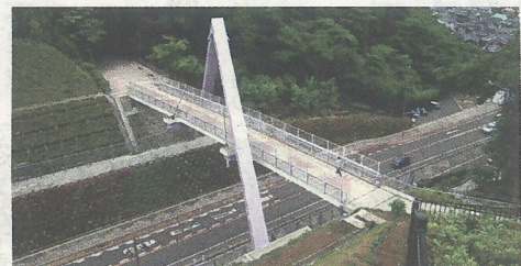
福井県鯖江市 逆V型主塔斜張橋 2004年(平成16年) 橋長40.0m 幅員4.0m 市道 国道417号 酒井鉄工所
