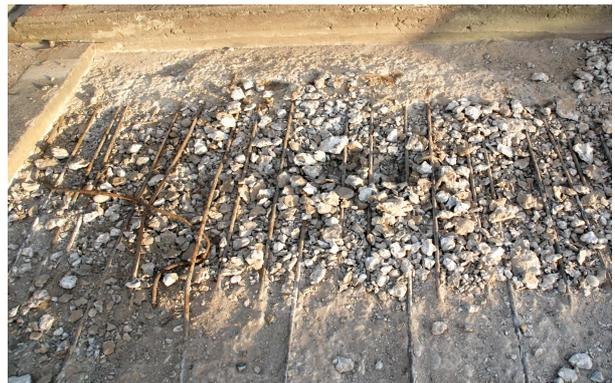
写真2：床版上面損傷例
