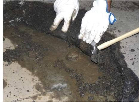
写真3：舗装を撤去した状態
