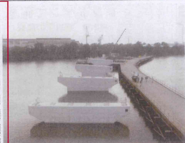
下部工進む新高梁川橋梁(水島側)
