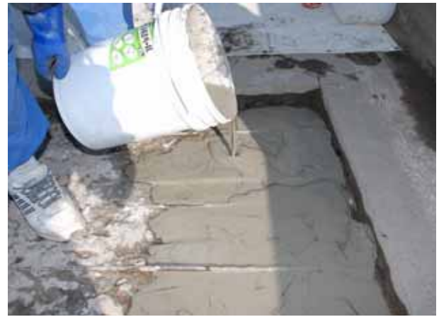
写真3 高機能セラミック素材による床版補修作業
