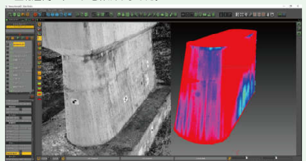
●三次元スキャナーにて得られた橋梁の点群データ上に、工場製作する補強鋼板の三次元モデルデータを付加して、現場の橋脚と補強鋼板の整合性チェックをしました。
